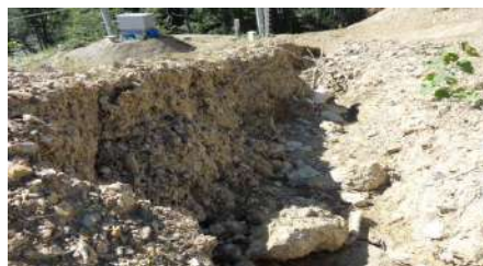
Рисунок 3 - Проявление сильной водной эрозии (размыв) по линии лыжных трасс
