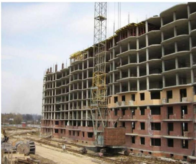
Рисунок 1 – Высокоэтажное строительство на высокопрочном бетоне
