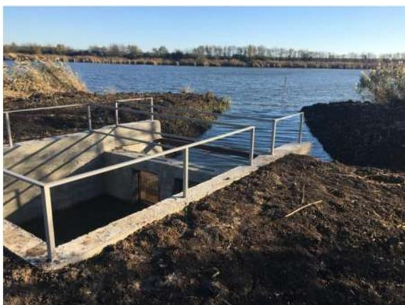
Рисунок 3 – Аванкамера с рыбозащитными устройствами
