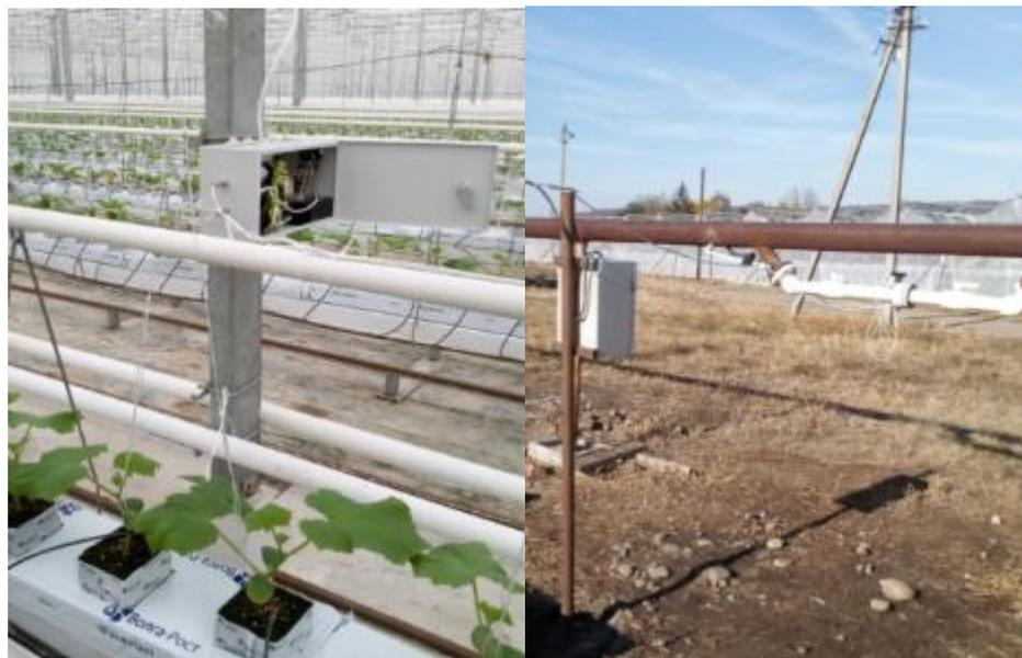
Рисунок 4.12 – Шкаф с элементами и устройствами автоматического управления акусто-магнитным аппаратом
