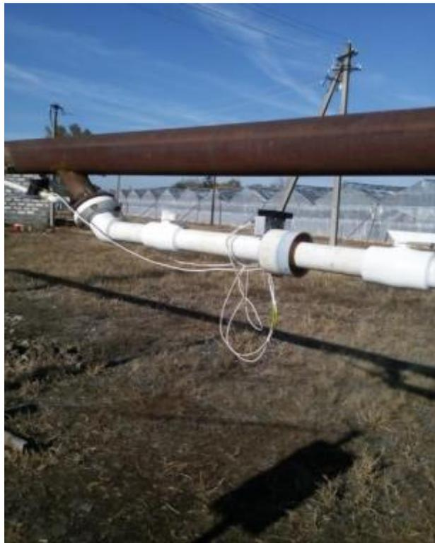
Рисунок В.4 – Изображение акусто-магнитного аппарата, установленного на трубе гидротермального источника
