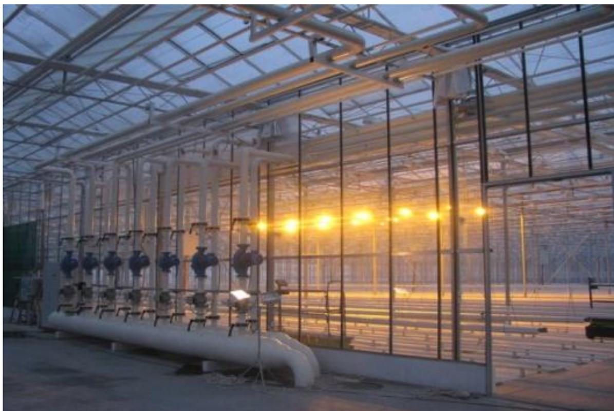
Рисунок 1.3 – Фрагмент системы водяного отопления тепличного комплекса [203]
