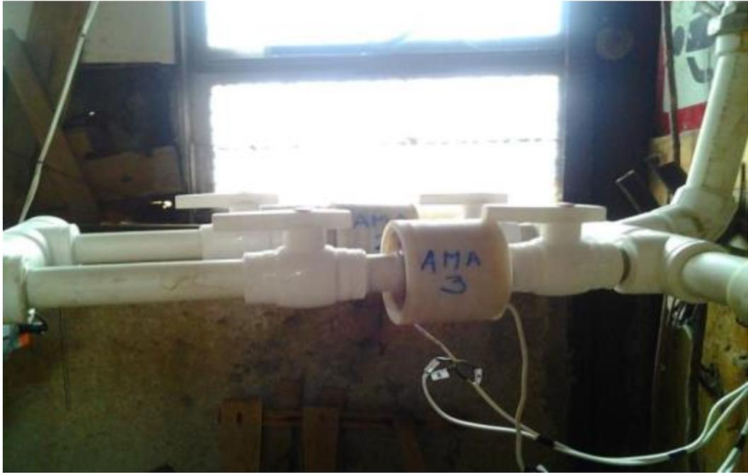
Рисунок В.1 – Внешний вид акусто-магнитных аппаратов, установленных в систему отопления на гидротермальных источниках
