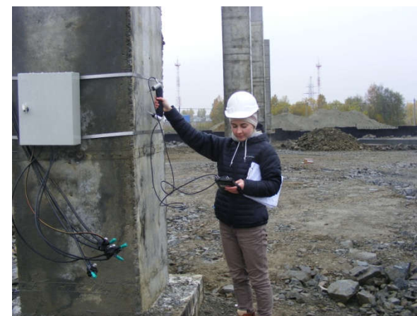
Рисунок 1 – Определение прочности бетона колонн с применением ультразвукового прибора ПУЛЬСАР – 2.1
