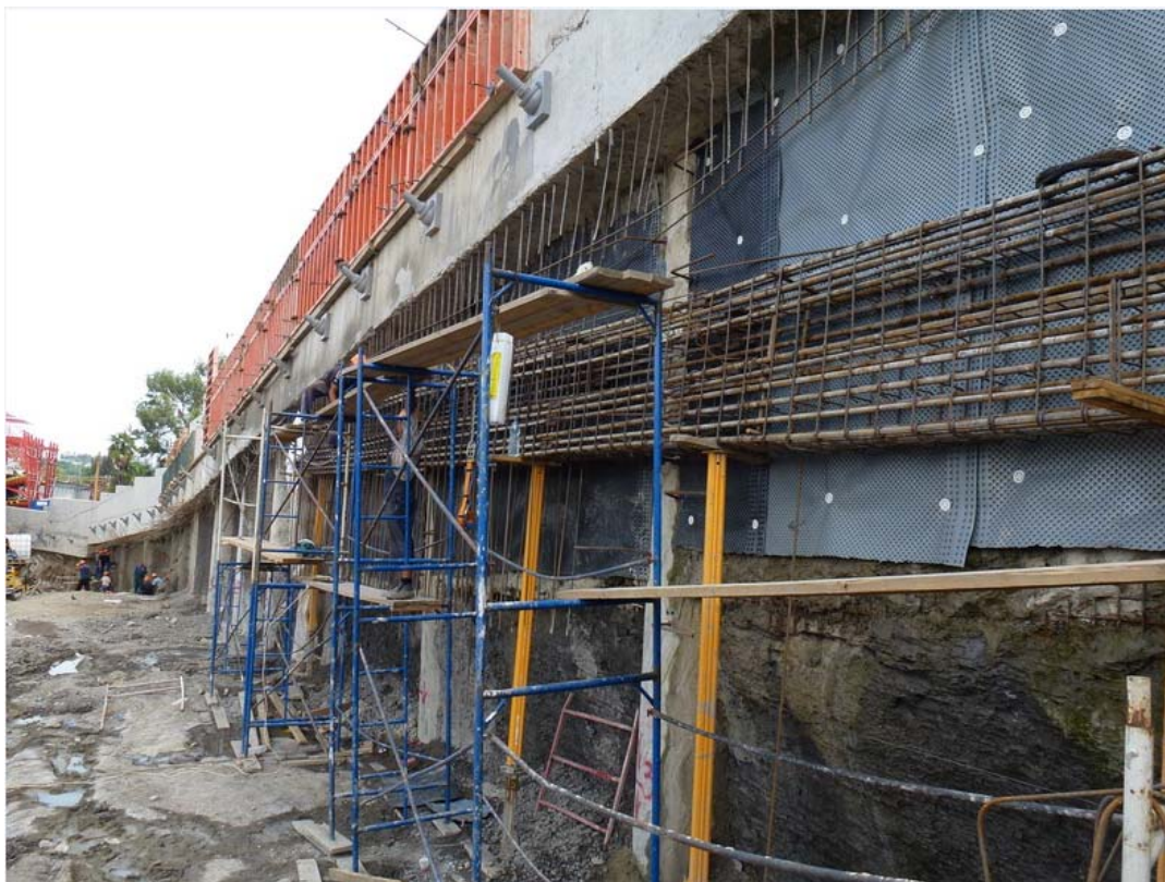
Рисунок 4.28 – Устройство облицовочной панели сооружения ПС-1-9/1
