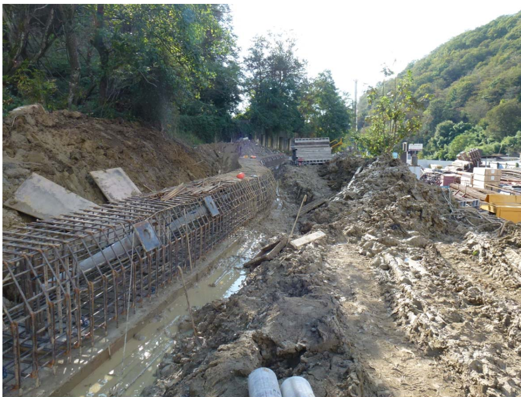
Рисунок 4.10 – Начало строительства сооружения ПС-Р-19
