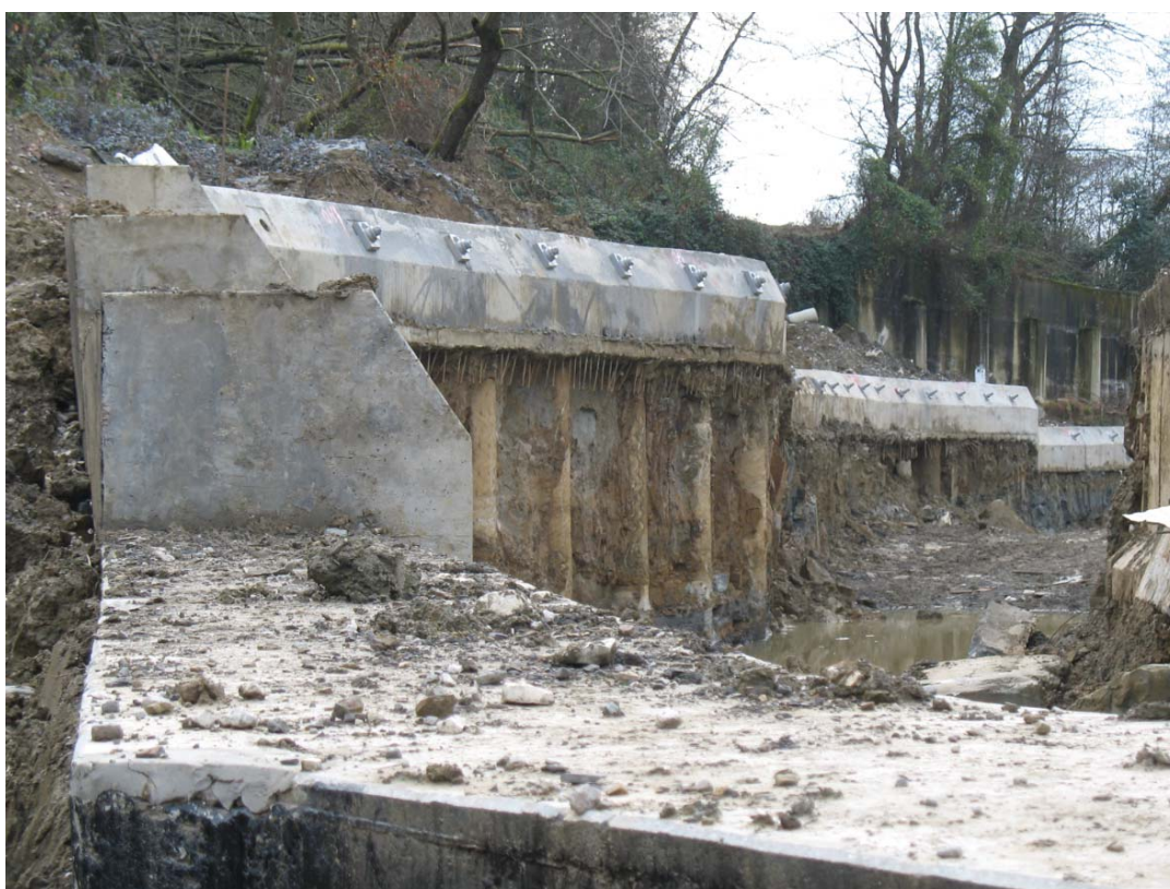
Рисунок 4.11 – Процесс строительства сооружения ПС-Р-19
