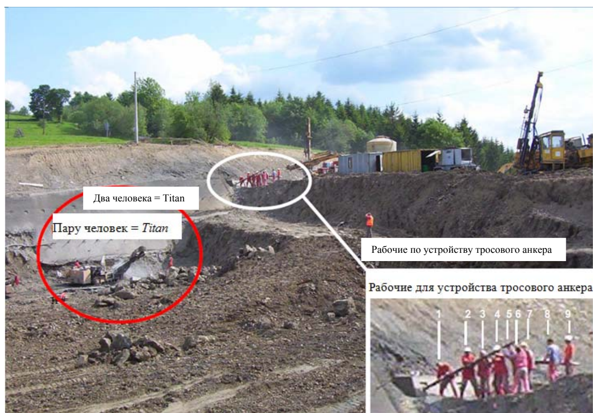
Рисунок 3.1 – Более высокая технологичность устройства анкерных свай в сравнении со стандартными тросовыми анкерами
