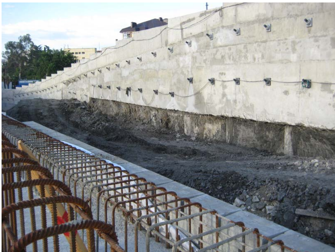
Рисунок 4.28 – Процесс строительства сооружения ПС-1-9/1
