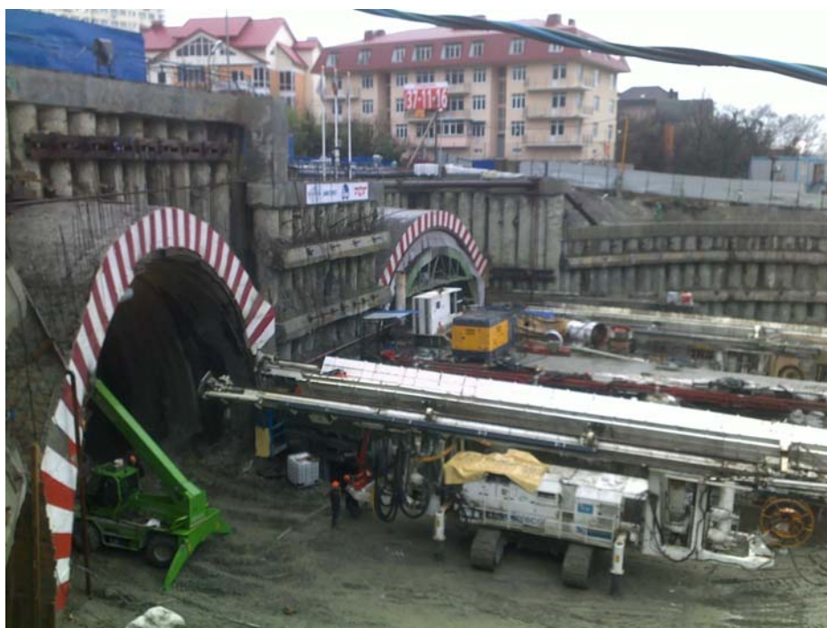
Рисунок А2 – Инженерная защита (припортальные стены) тоннеля № 8 на объекте «Дублер Курортного проспекта. III очередь»
