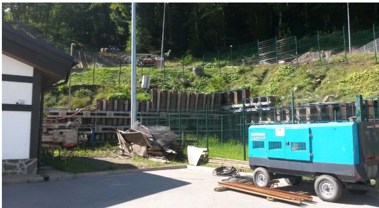
Рисунок А8 – Горноклиматический курорт «Альпика-Сервис», в том числе объекты олимпийской инфраструктуры, канатная дорога «Аибга-2» и сооружения инженерной защиты. Существующая шпунтовая стенка в районе газораспределительной станции на отм. +550, 2016 г.
