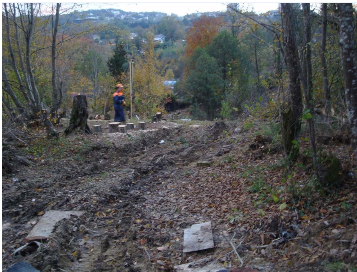
Рисунок 4.1 – Участок строительства сооружения ПС-Р-3
