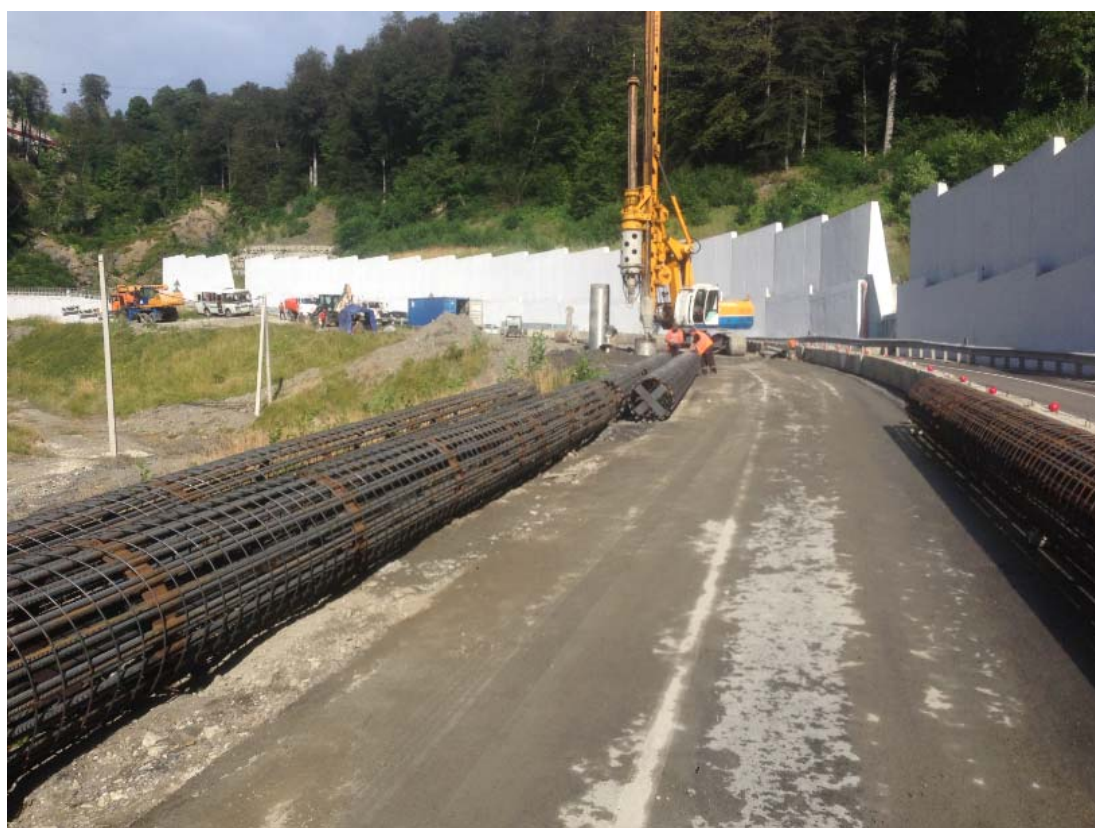
Рисунок А13 – Противооползневые мероприятия на участках автодороги АД-21 км2, км5, км7 и км9, 2016 г.
