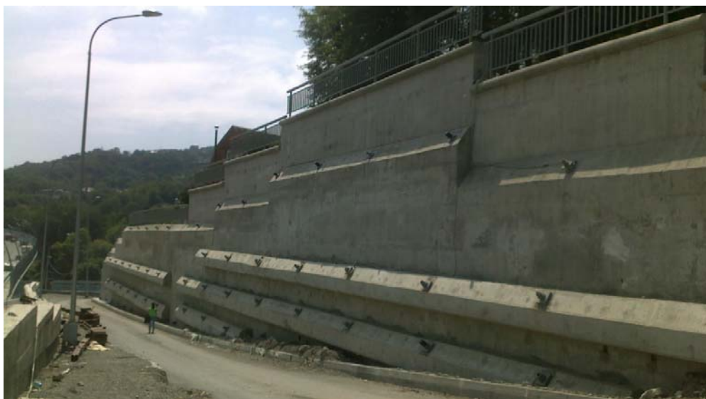
Рисунок 4.3 – Завершение строительства сооружения ПС-Р-3
