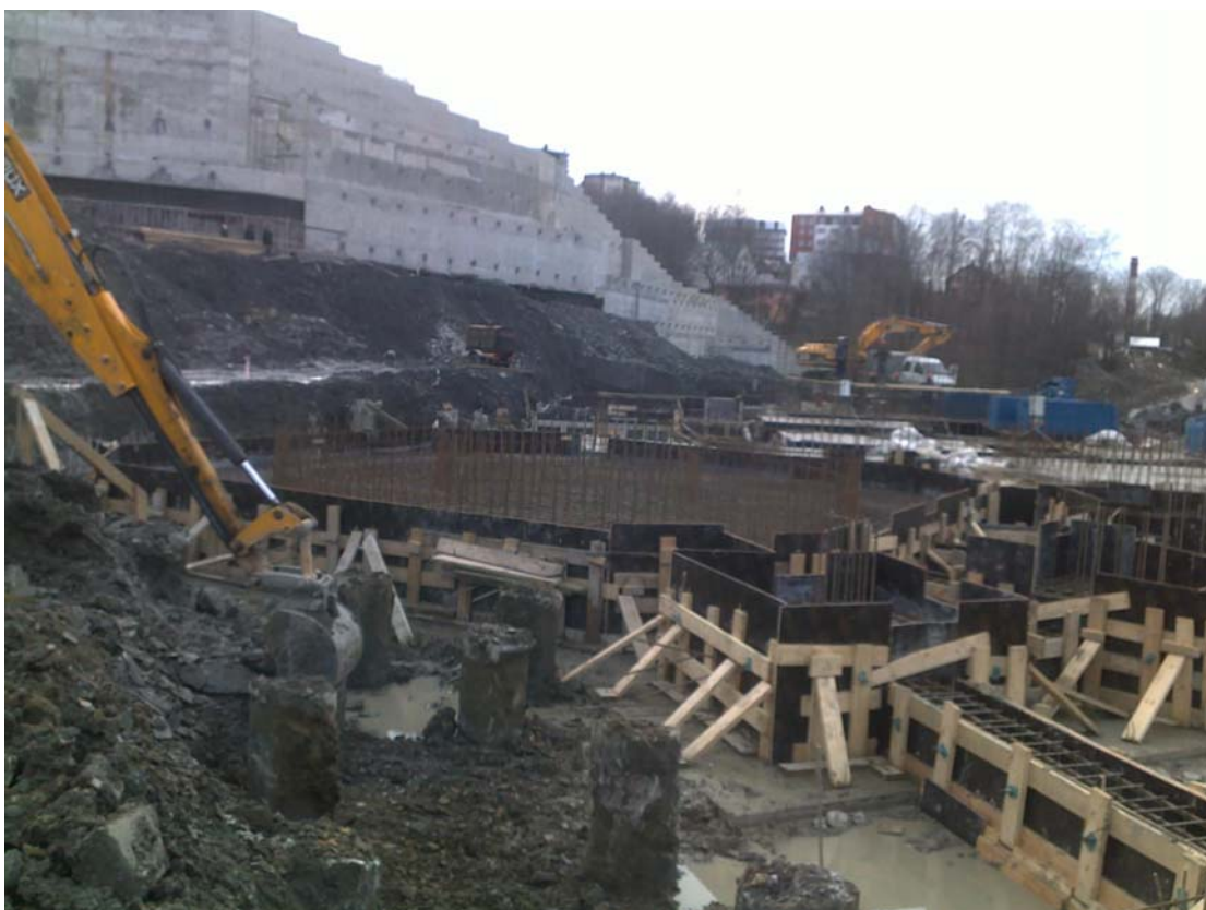
Рисунок А3 – Противооползневые свайно-анкерные сооружения для защиты здания инженерного корпуса (перепад высот более 25-ти метров) на транспортной развязке «Фабрициуса» на объекте «Дублер Курортного проспекта. II очередь»
