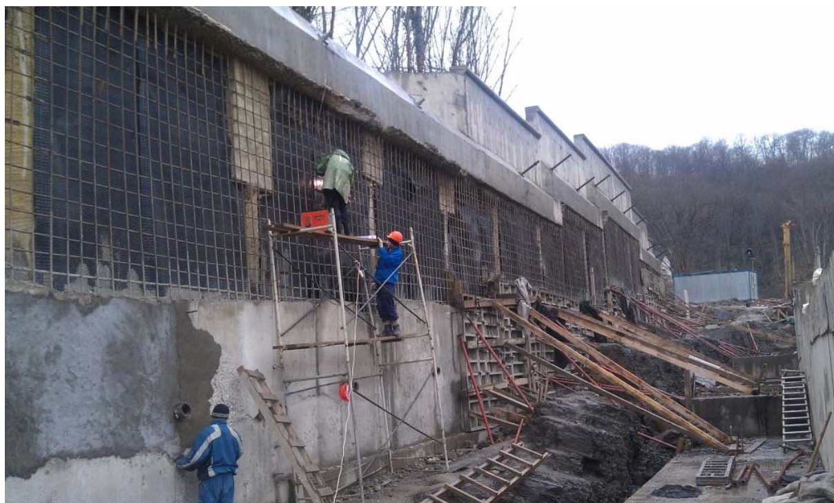
Рисунок 4.2 – Процесс строительства сооружения ПС-Р-3
