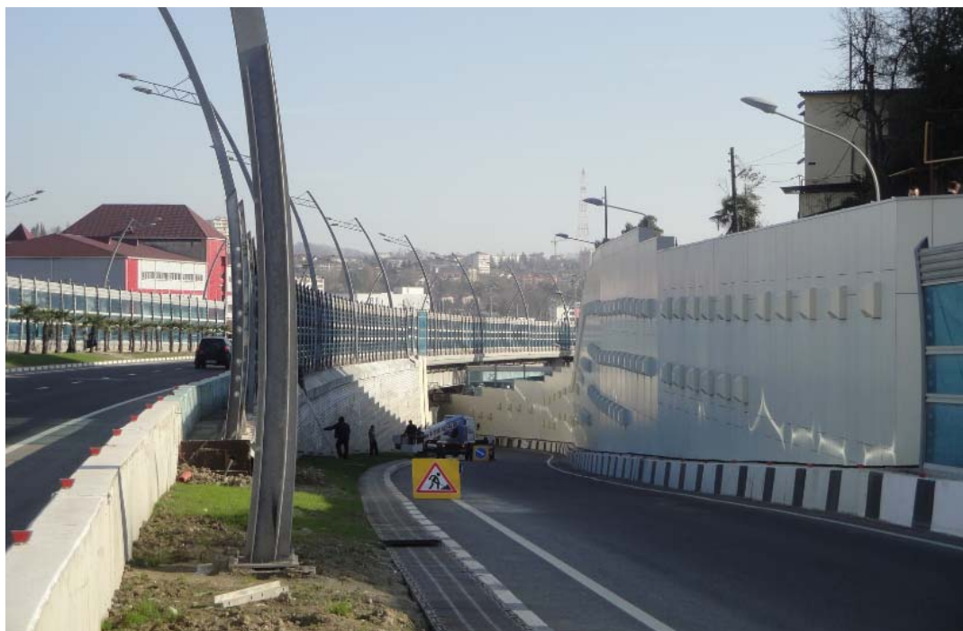
Рисунок 4.28 – Завершение строительства сооружения ПС-1-9/1
