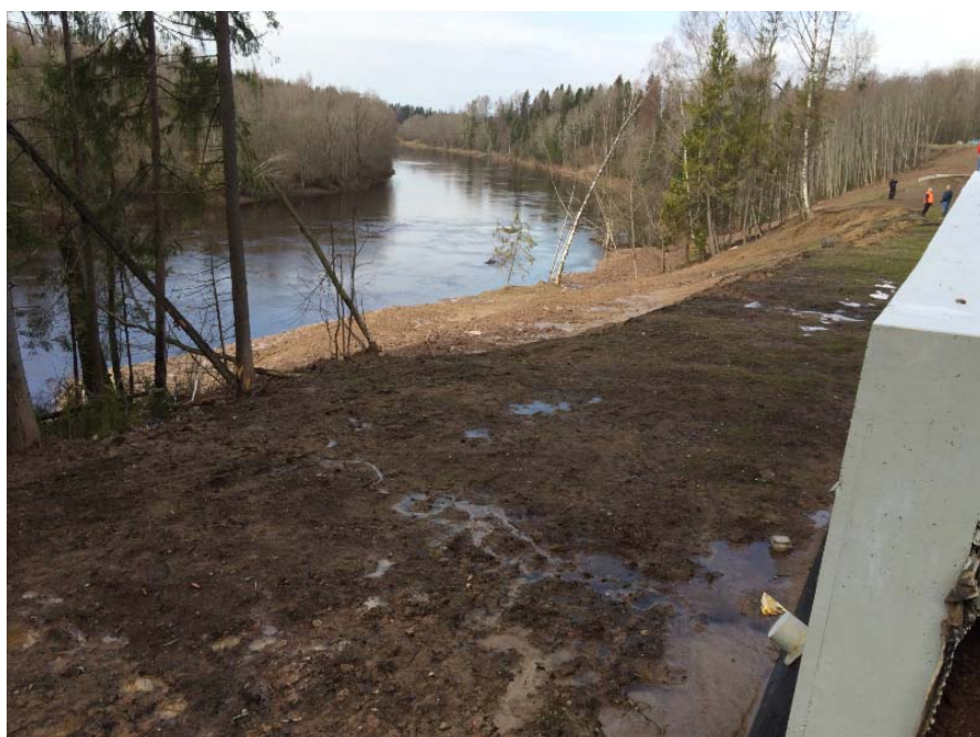
Рисунок А7 – Противооползневые мероприятия на участке автодороги Вологда – Новая Ладога, 2016 г.
