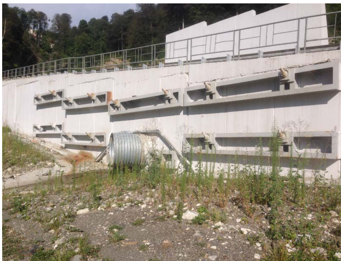
Рисунок А12 – Противооползневые мероприятия на участках автодороги АД-21 км2, км5, км7 и км9, 2016 г.
