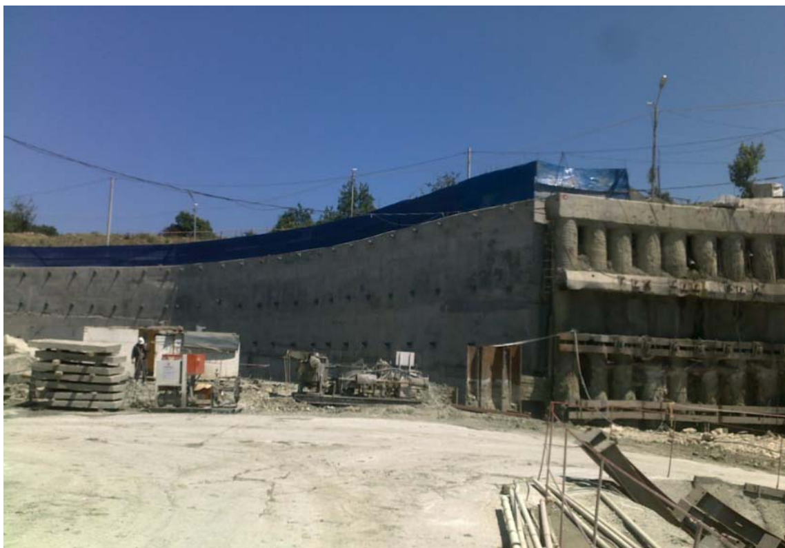
Рисунок 4.38 – Процесс строительства сооружения ПС-4-1
