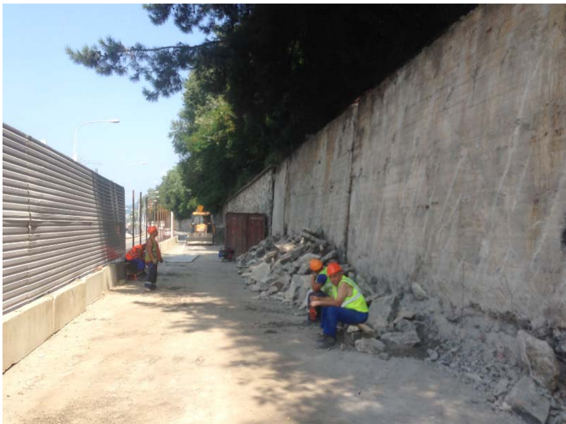
Рисунок А10 – Реконструкция противооползневых сооружений на автодороге А-147 Дзубга-Сочи на участках км189-191 и км195-196, 2016 г.
