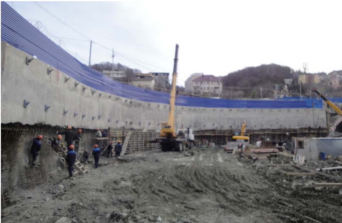
Рисунок 4.37 – Устройство нижнего яруса сооружения ПС-4-1
