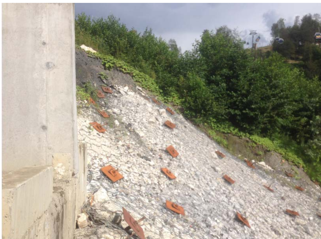
Рисунок А14 – Противооползневые мероприятия на участках автодороги АД-21 км2, км5, км7 и км9, 2016 г.
