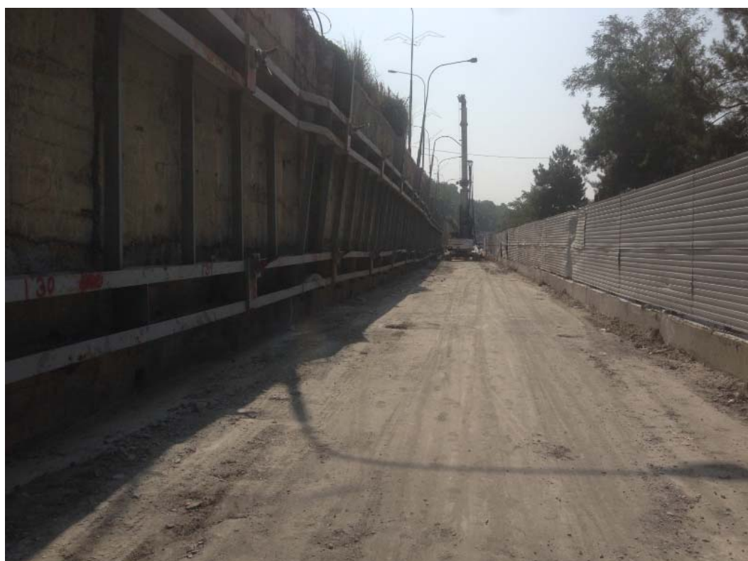
Рисунок А9 – Реконструкция противооползневых сооружений на автодороге А-147 Дзубга-Сочи на участках км189-191 и км195-196, 2016 г.
