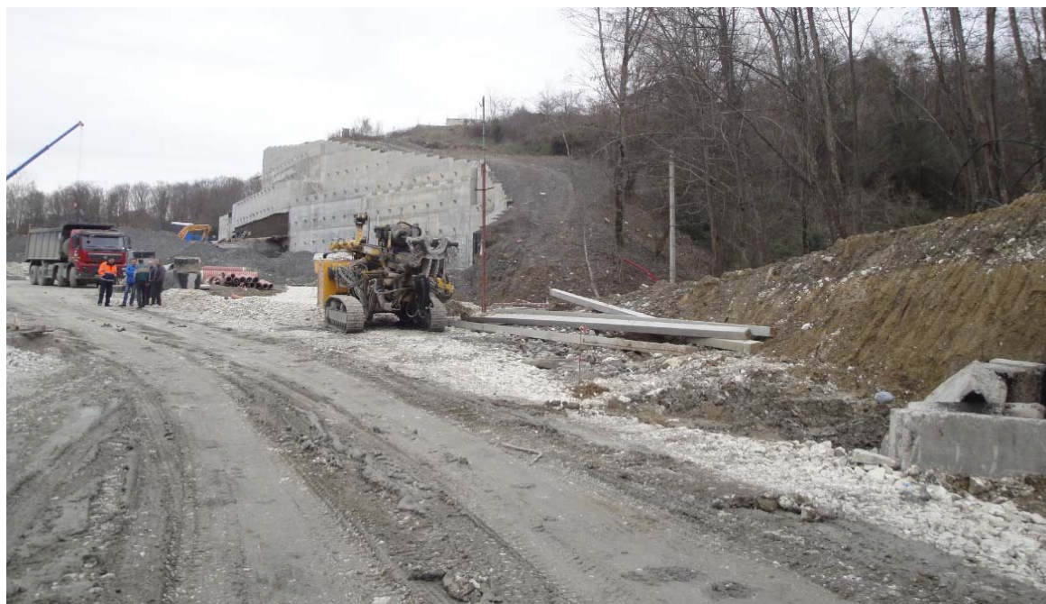
Рисунок 4.20 – Процесс строительства сооружения ПС-Ф-42
