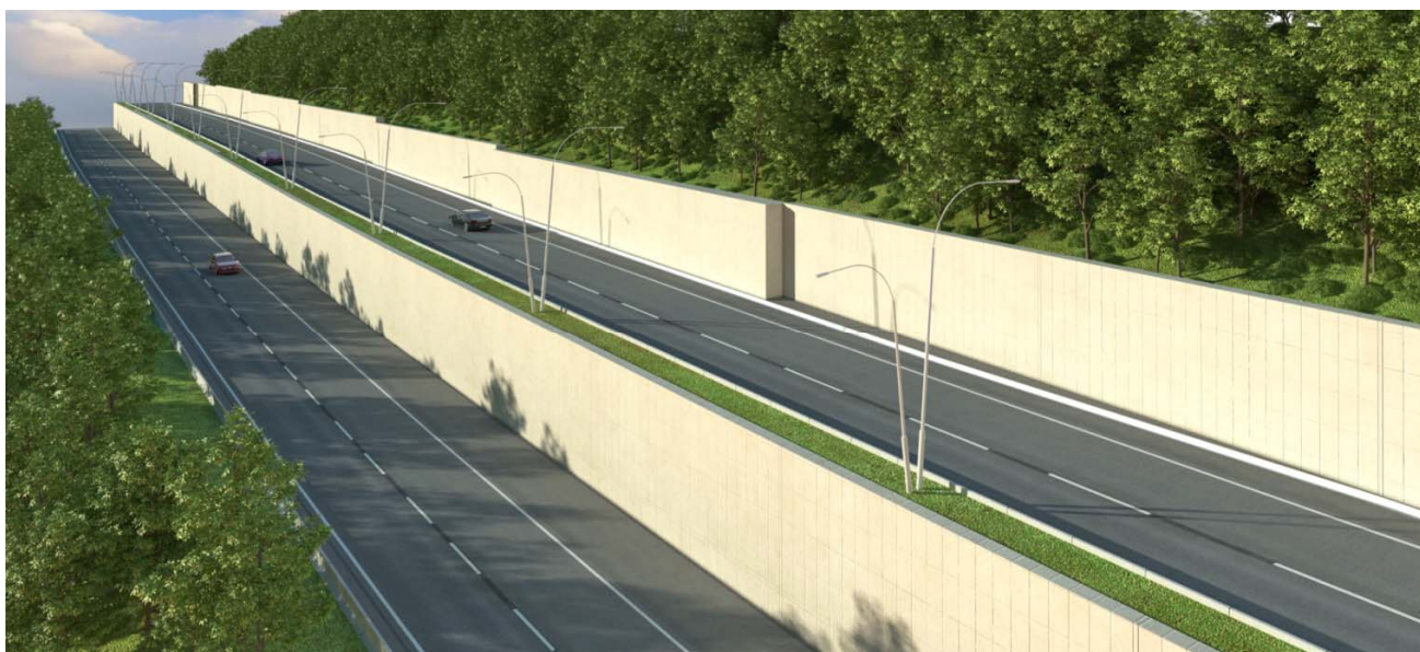
Рисунок А11 – Реконструкция противооползневых сооружений на автодороге А-147 Джубга-Сочи на участках км189-191 и км195-196, 2016 г.
