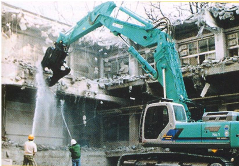
Рисунок 3.17 – Снос многоэтажного здания с помощью гидроножниц и удлинённой стрелы
