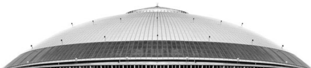
Рис. 6.20. Система измерения высоты снежного покрова
