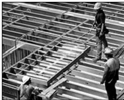
Рис. 5.1. Металлокаркас, состоящий из легких стальных тонкостенных конструкций
