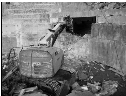
Рис. 8.7. Алмазное пиление (а) и смешанный способ демонтажа с применением роботов Brokk (б)
