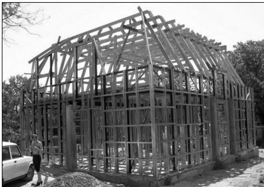
Рис. 7.18. Строительная система Термокаркас
