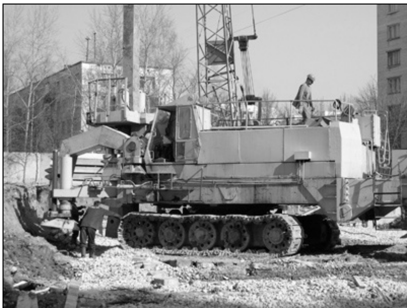
Рис. 3.16. Способ устройства инъекционной сваи
