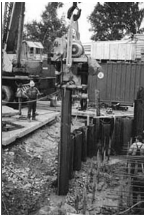
Рис. 3.1. Шпунтовое ограждение
