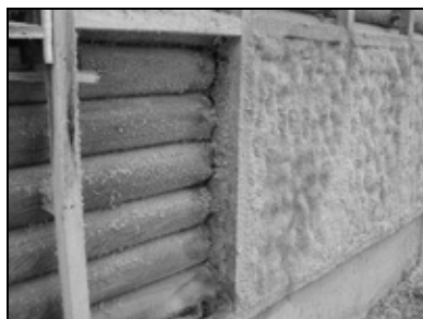
Рис. 7.20. Пример напыления эковаты
