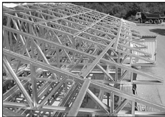
Рис. 5.6. Стальные фермы покрытия
