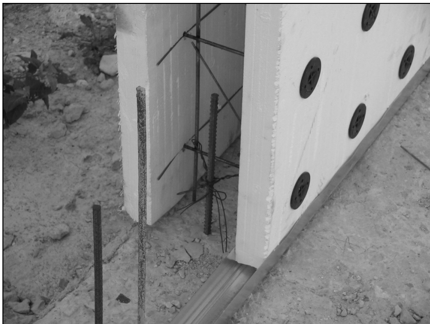
Рис. 7.24. Конструктивные элементы системы PLASTBAU:
