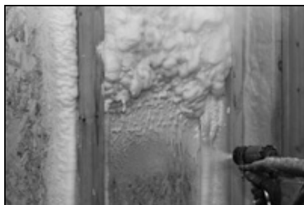
Рис. 7.21. Утепление деревянных конструкций
