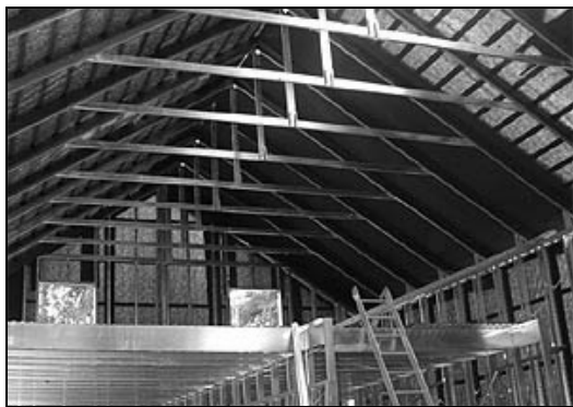
Рис. 5.7. Стальные балки перекрытия
