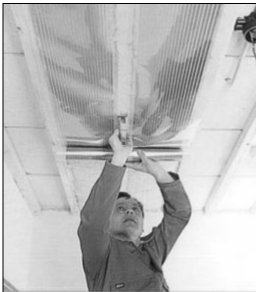
Рис. 6.29. Монтаж греющей фольги Alson
